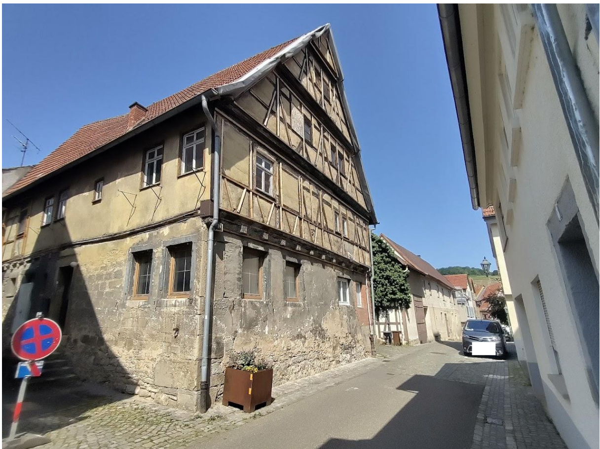
Abb. 7: Entengasse 10 von Südwesten
