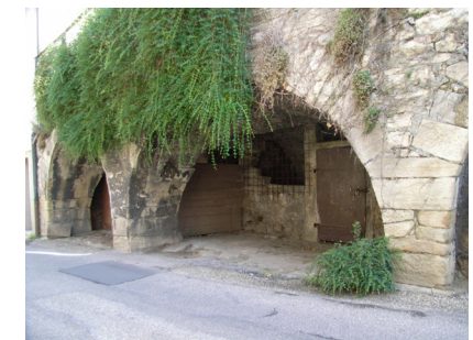
Gewölbe des Kellers
