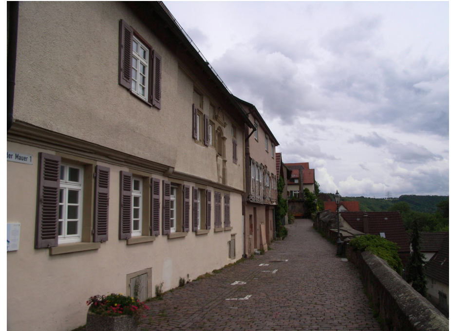
Abschnitt an der Mauer (❷)
