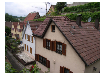
Blick von der Brücke (Turmstraße)
