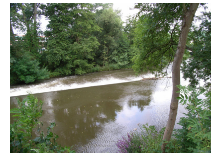
Streichwehr zur Burgermühle
