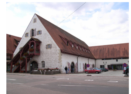
Hofansicht der alten Kelter
