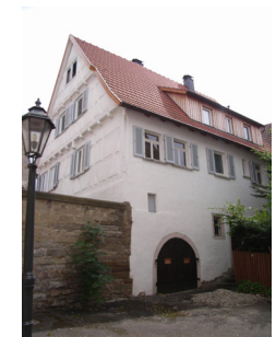
Ansicht von Norden mit Kellertor)
