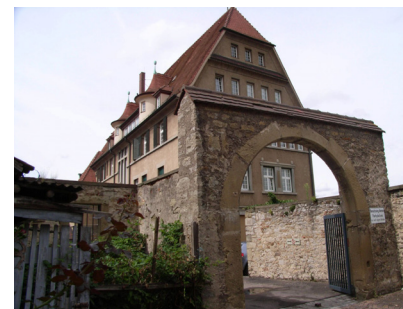
Ansicht von Süden mit Tor
