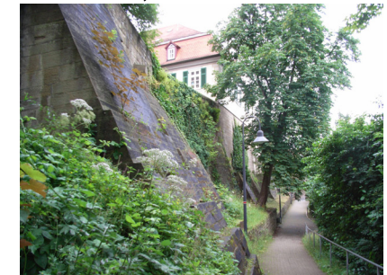
Innere Stadtmauer unterhalb der Kirche
