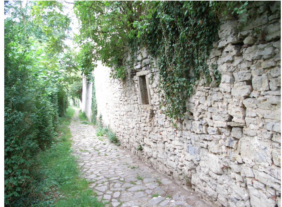
Äußere Stadtmauer im Nordwesten, zu Vorstadt 19, 23, 25
