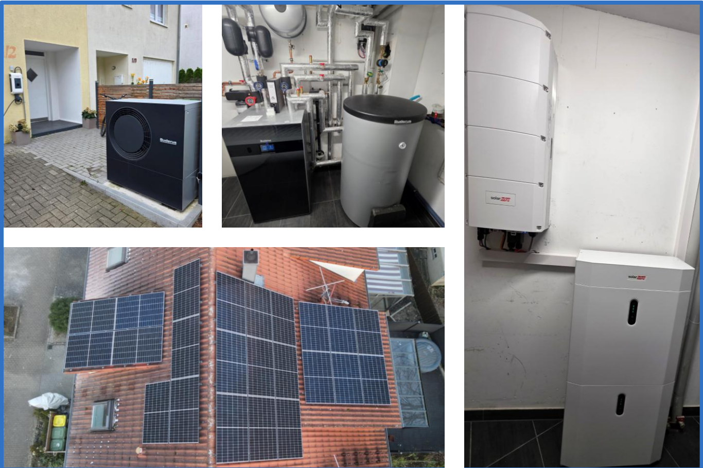
Von links nach rechts: Wärmepumpe außen, Wärmepumpe im Heizraum , Wechselrichter für PV-Anlage, PV-Module auf beiden Dachseiten
