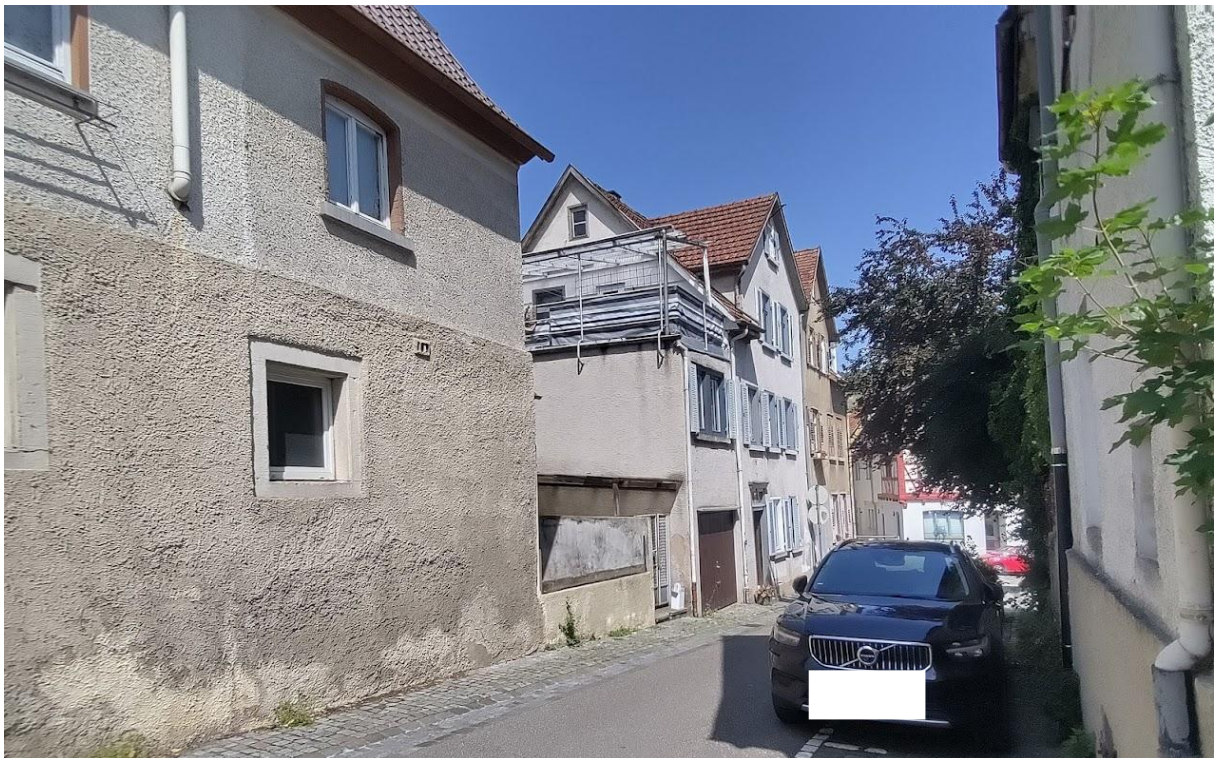
Abb. 6: Entengasse 6, 4 und Hauptstraße 40 von Südwesten
