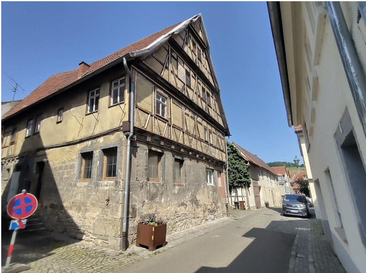
Abb. 7: Entengasse 10 von Südwesten
