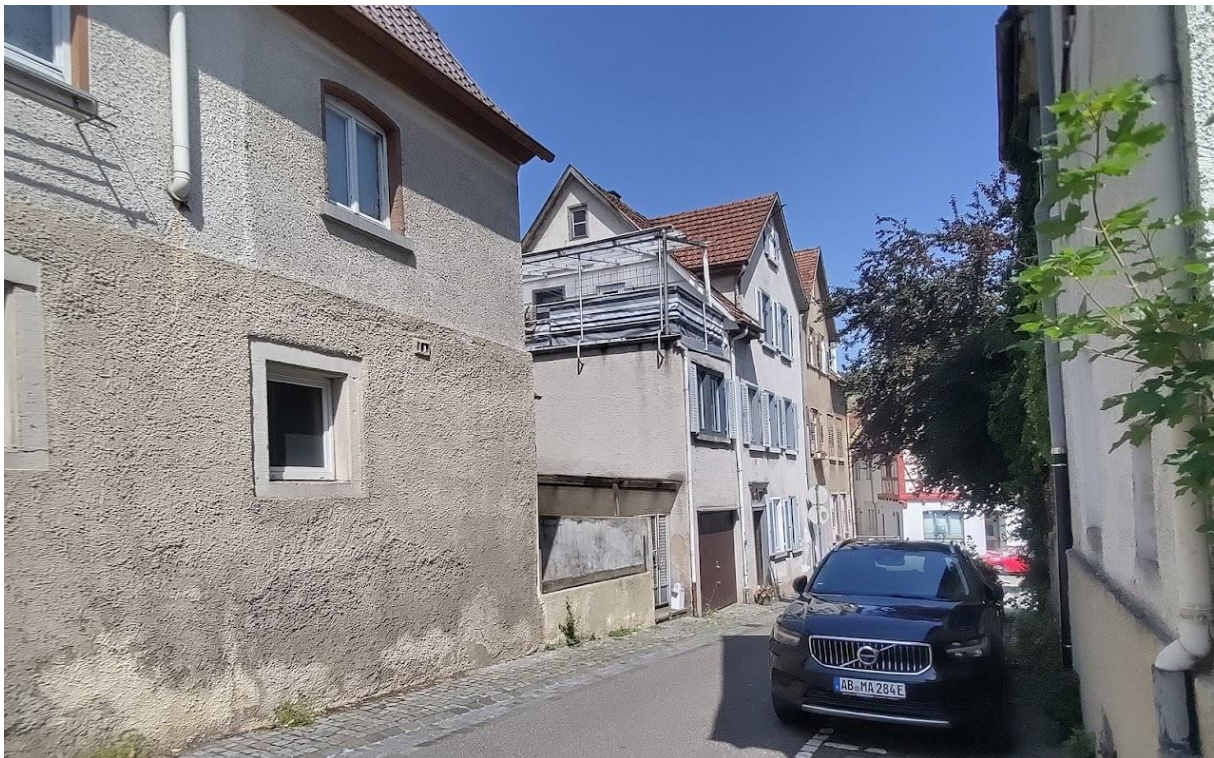
Abb. 6: Entengasse 6, 4 und Hauptstraße 40 von Südwesten
