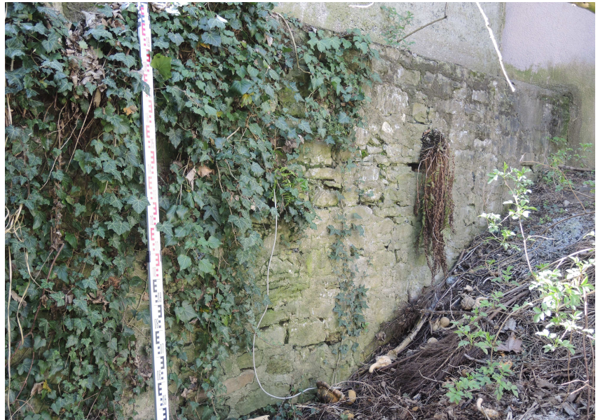
Abb. 2 - Ansicht des Mauerabschnitts von Nordosten (2026)
