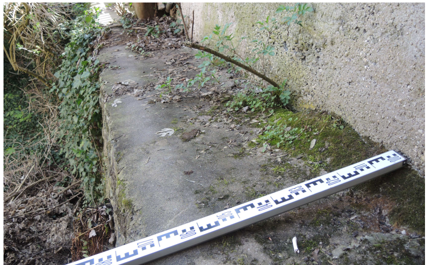
Abb. 3 - Ansicht der Mauerkrone (2026)
