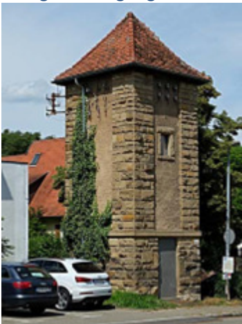
Enzweg 2: Trafostation, 1920er/30er Jahre, anspruchsvoll gestalteter baulicher Hinweis auf die Geschichte der Energieversorgung.
