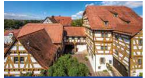
Fachwerkführung Altstadt Bietigheim
