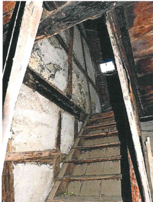
Flur und Treppe zum DG
