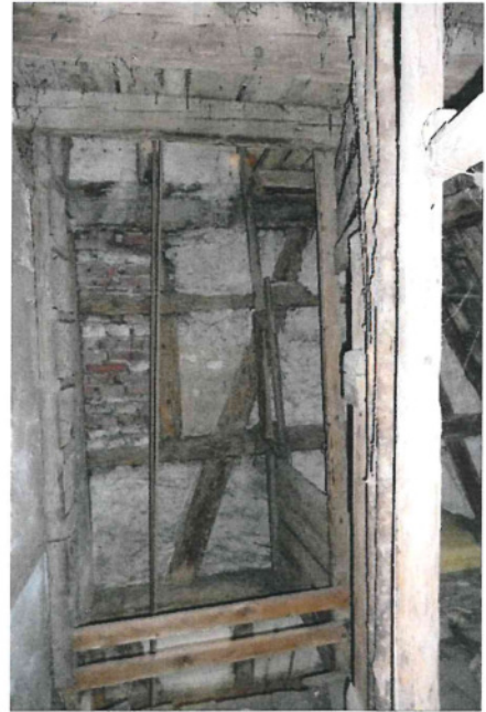
Schacht von der Scheune zum Dachboden
