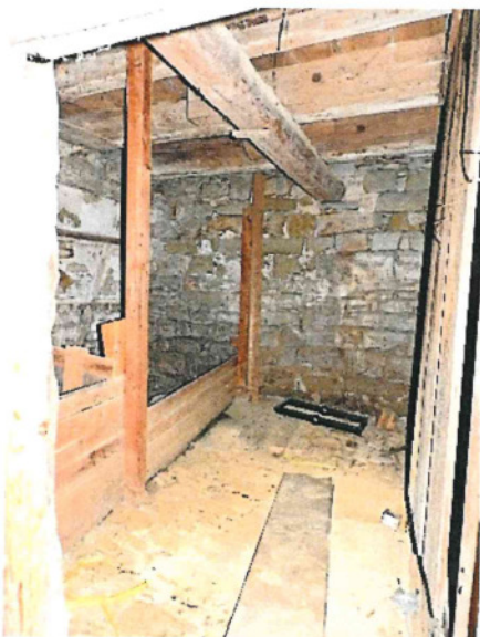
Stall an der Nordseite
