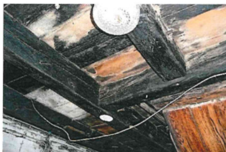
Decke im Treppenhaus
