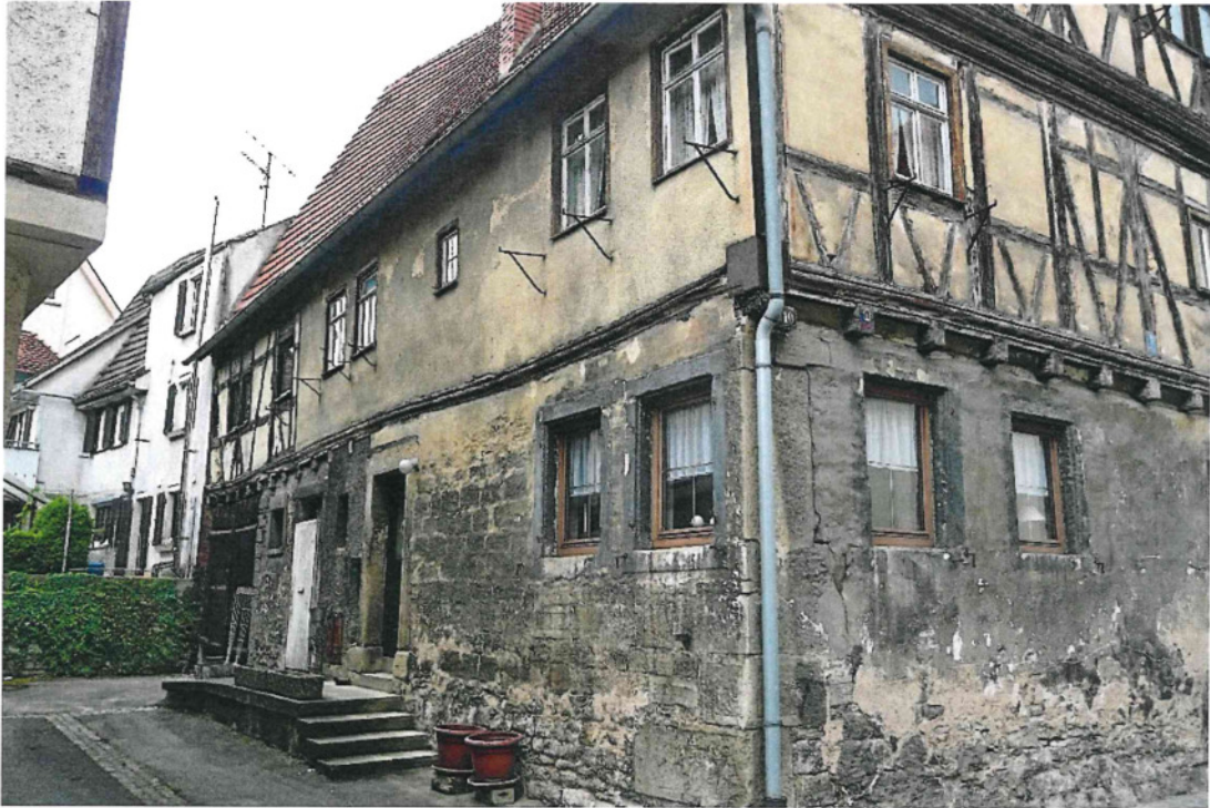
Ansicht von Süd-Ost
