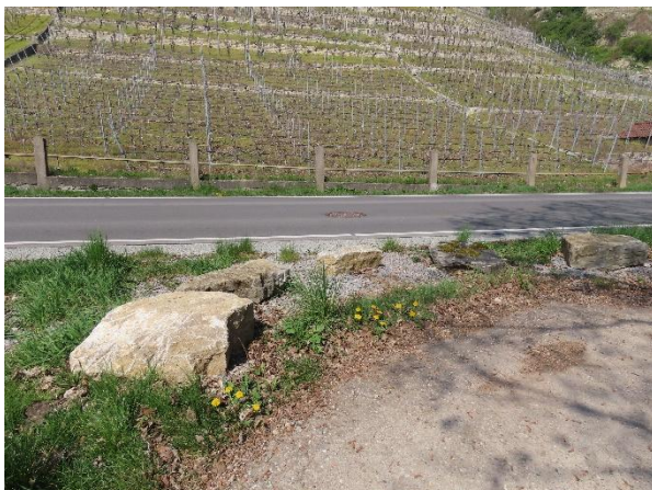
Abb. 14: Begrenzungssteine zwischen dem Feldweg im Plangebiet und der Hessigheimer Straße
